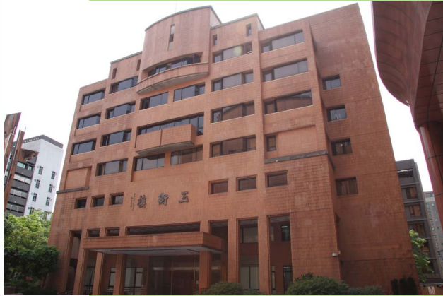
保訓會辦公大樓 CSPTC Office Building
