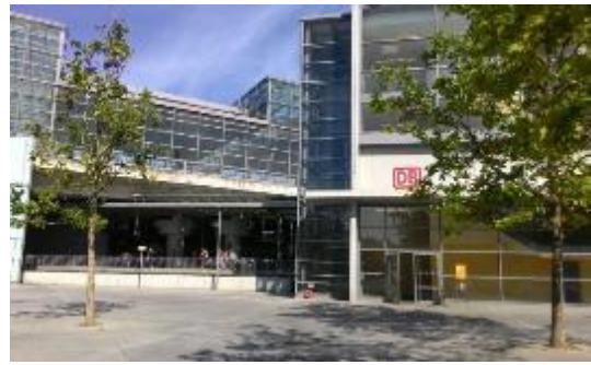
圖 4-42 十字車站辦公大樓內提供電動車研究的辦公室
