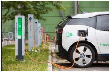
圖 4-21 不同類型的充電柱(用電線)
