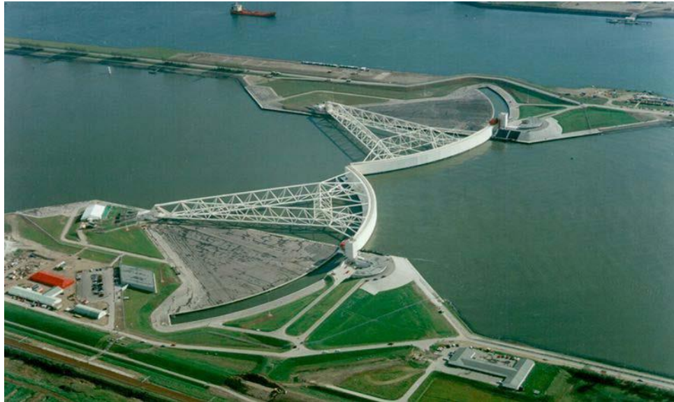
圖四、荷蘭三角洲出海口環狀防洪閘門
