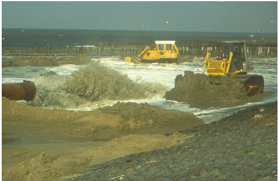
圖三、荷蘭海砂補償工程
