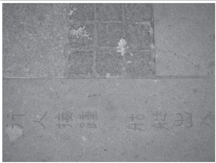
【圖5】臺南神農街街屋文化保存工程，街道鋪面石材取自於壓倉石概念，地面刻寫早期歷史地理位置，頗具質感。
